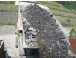
原石のプラント投入
